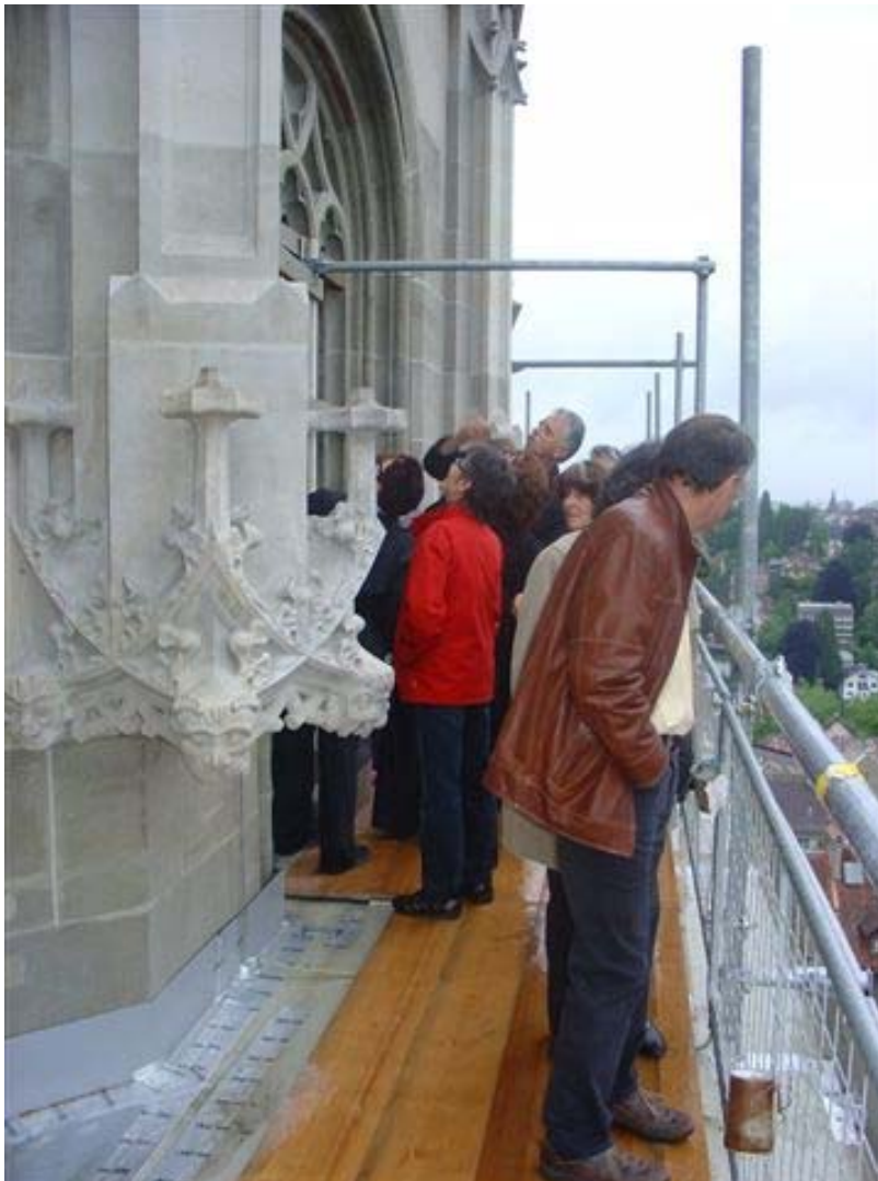
Diese Attraktion bleibt den Besuchern sonst verwehrt: Ein Blick vom Turmgerüst.
