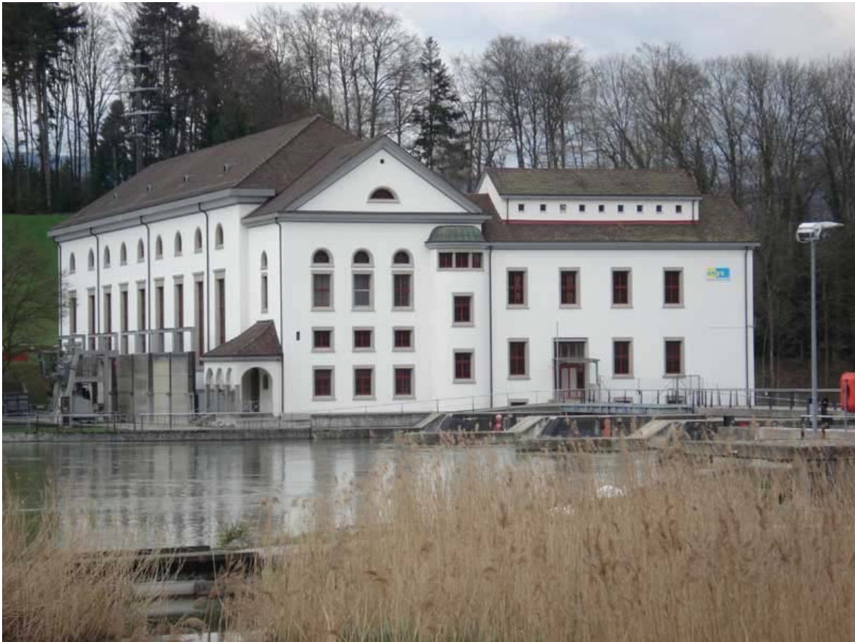
Das alte Turbinenhaus ist nach wie vor voll in Betrieb.
